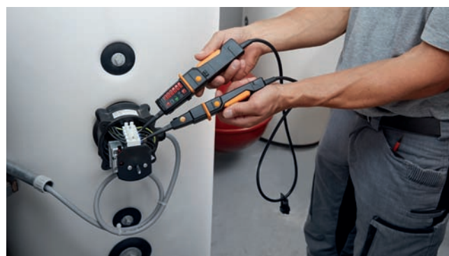
Измерение напряжения на бойлере
