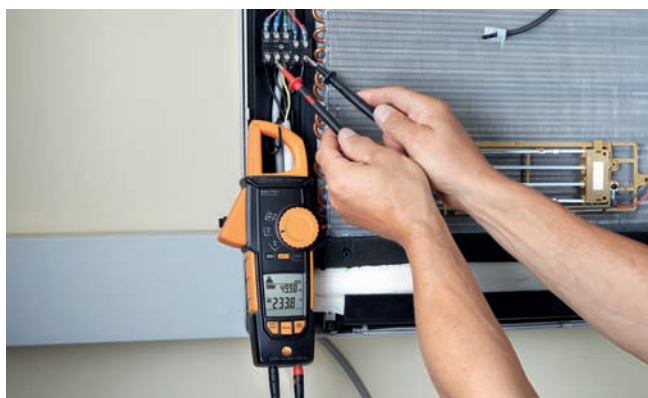
Измерение напряжения на блоке кондиционера с testo 770
