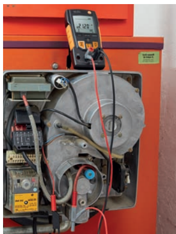
Измерение потока ионизации с testo 760
