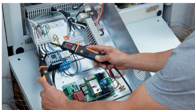
Измерение напряжения на компрессоре
