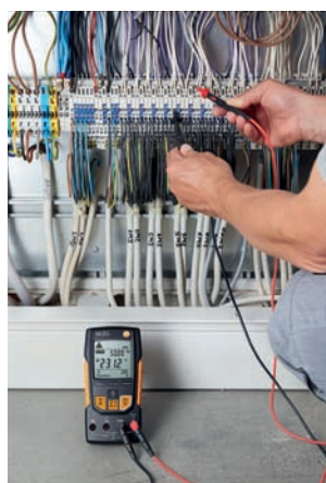
Проверка напряжения в распределительном щитке
